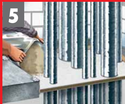
5 Erstes Befüllen Deckenöffnung mit Trockenschüttung befüllen und gleichmäßig im Schacht verteilen
