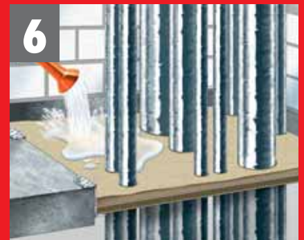
6 Erstes Anfeuchten Trockenschüttung mit Wasser anfeuchten - 0,5 l pro kg Trockenschüttung
