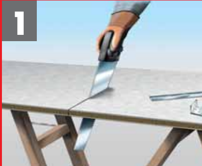
1 Zuschneiden der Deckenplatte (zugeschnittene Deckenplatten auf Anfrage) - z. B. mit Stichsäge oder Säbelsäge
