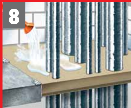
8 Zweites Anfeuchten Trockenschüttung nochmals mit Wasser anfeuchten
