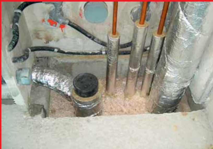
Deckendurchführung mit IBS 90 Trockenschüttung.
